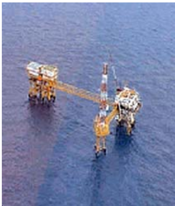
Cayo Arcas Platform
