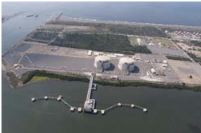
Manzanillo LNG Terminal
