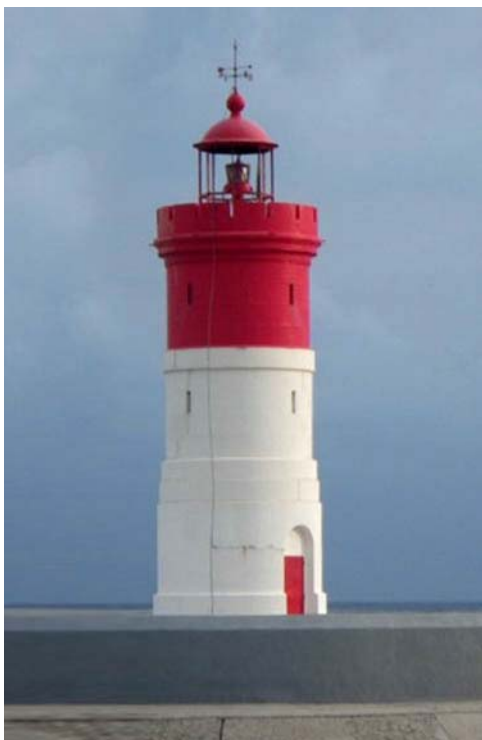
Dique de Navidad Light
