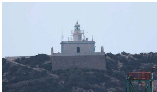
Isolete de Escombreras Light
