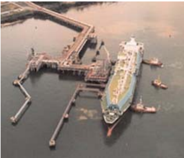
LNG Jetty—Berth No. 2
